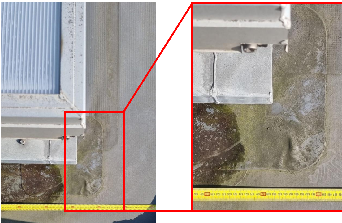
Figure 7 : Photographie de la distance de l'exutoire par rapport au mur coupe-feu (source : TARKETT)
